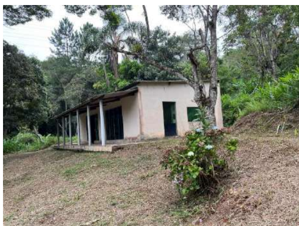
Foto 17 - Vista da fachada da área de festas (Ed 02).
