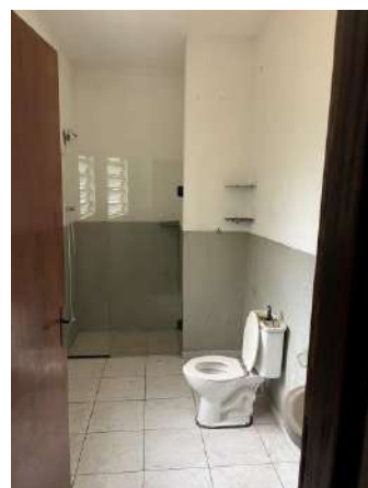
Foto 14 - Vista do banheiro da casa principal (Ed 01).
