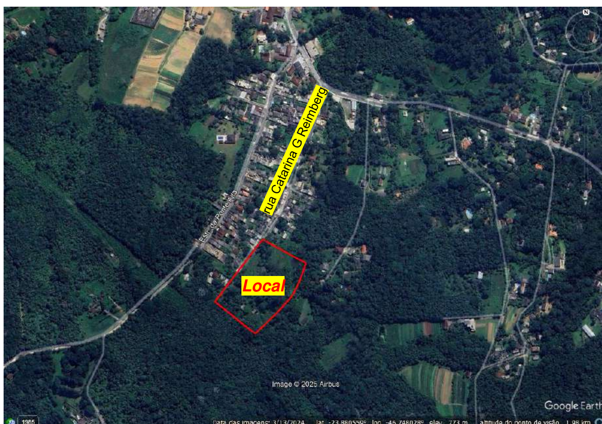
Figura 1 - Imagem aérea do imóvel objeto da perícia. (Fonte: adaptado de Google Earth)
