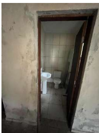
Foto 21 - Vista do banheiro da área de festas (Ed 02).
