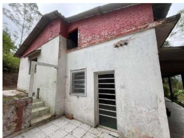
Foto 10 - Vista externa da casa principal (Ed 01).
