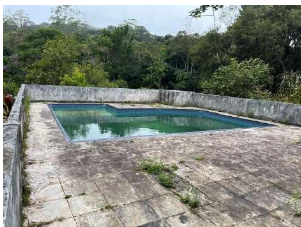
Foto 23 - Vista da área de banho (Ed. 03).
