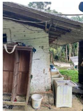
Foto 26 - Vista da casa do caseiro (Ed. 04).
