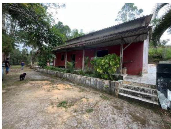
Foto 9 - Vista externa da casa principal (Ed 01).
