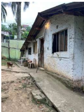
Foto 25 - Vista da casa do caseiro (Ed. 04).
