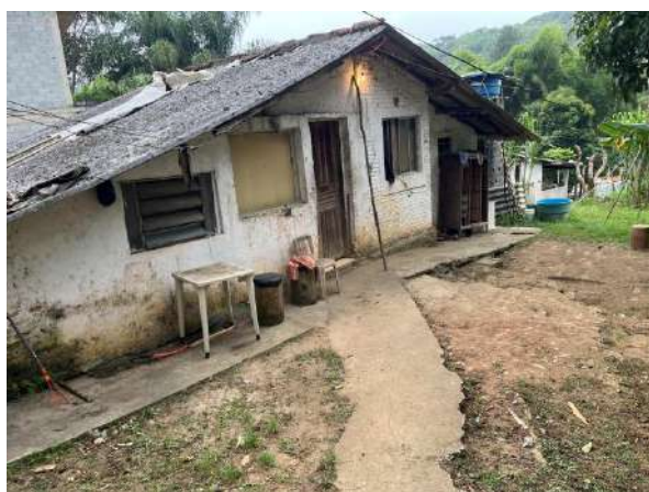
Foto 24 - Vista da casa do caseiro (Ed. 04).
