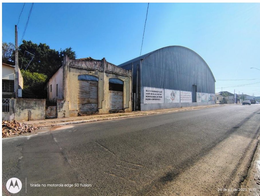
Imagem 3 – Vista frontal do imóvel
