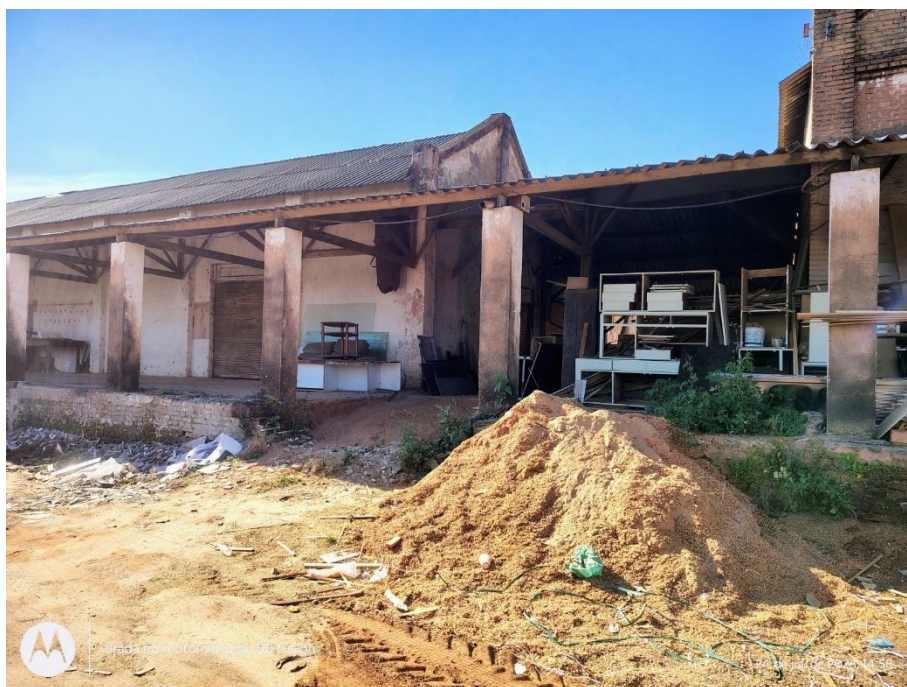
Imagem 15 – Rua sem saída – galpão 3 fundos
