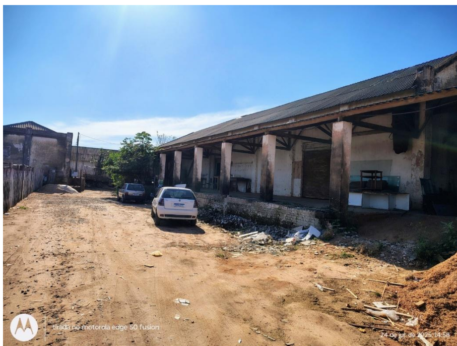
Imagem 16 – Rua sem saída – galpão 3 fundos
