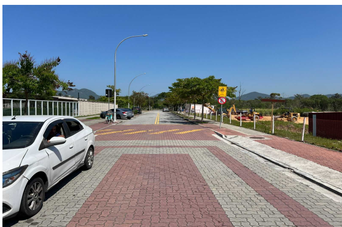
Rua Lado Direito - Condomínio
